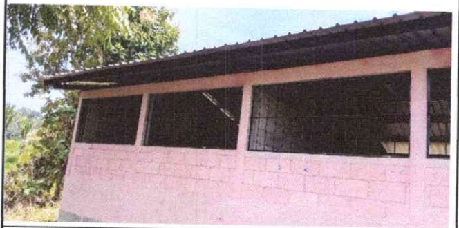
Foto 6: El entechado no cuenta con canaleta, sin embargo es necesita instalarlas.
